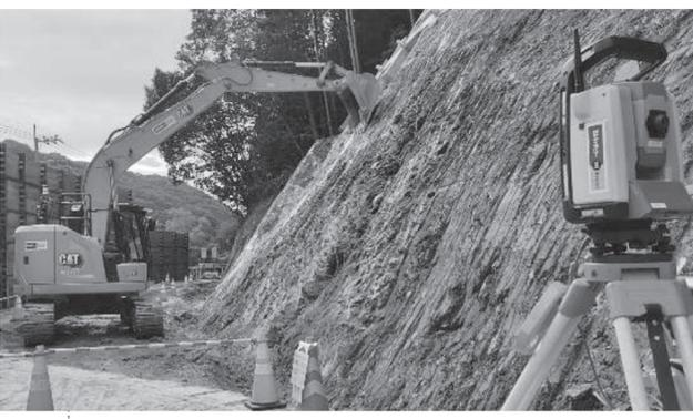
小規模工事におけるICT建機(MG)による整形
